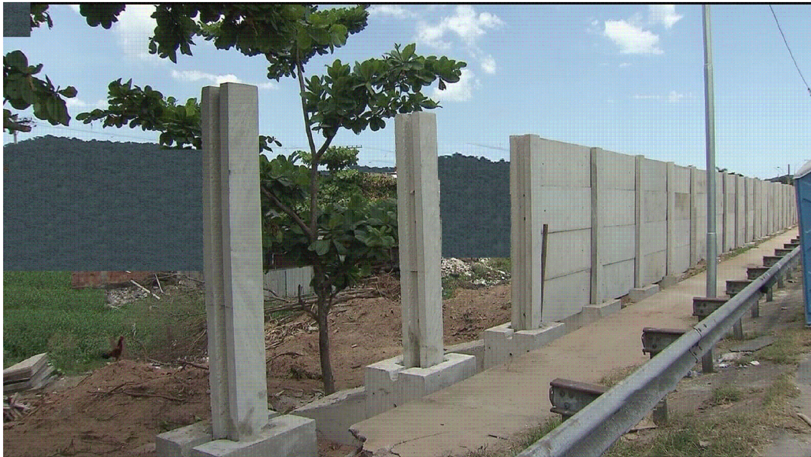
FOTO MURO PLACAS DE CONCRETO
