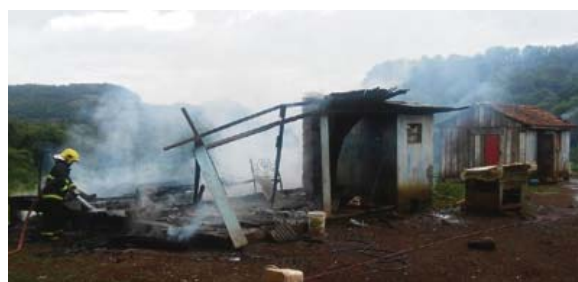
Residência mista ficou completamente destruída após incêndio
