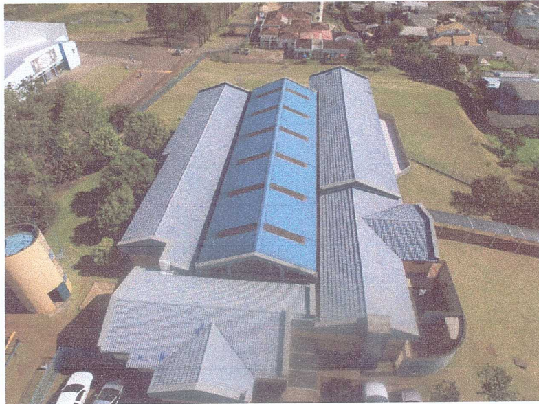
Usina 01 Colégio - Avenida Farrapos, nº 4 – Centro
