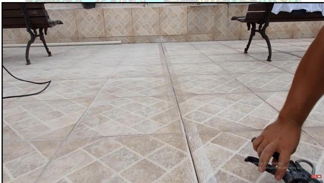
**Figura 29 – JUNTA DE DILATAÇÃO – EXECUÇÃO 2**
