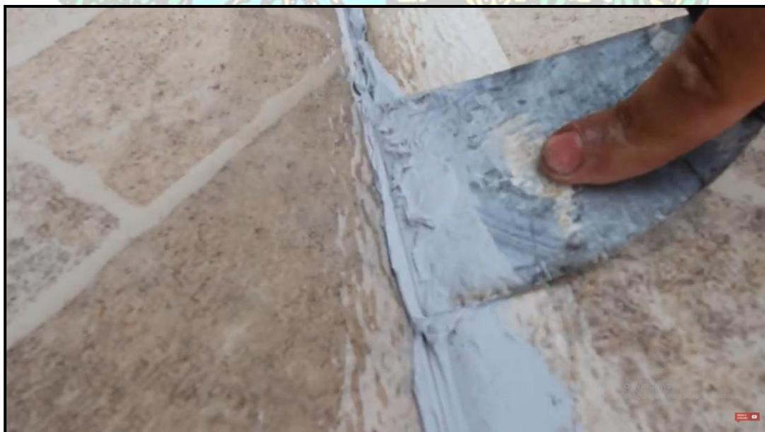
**Figura 31 – JUNTA DE DILATAÇÃO – EXECUÇÃO 4**
