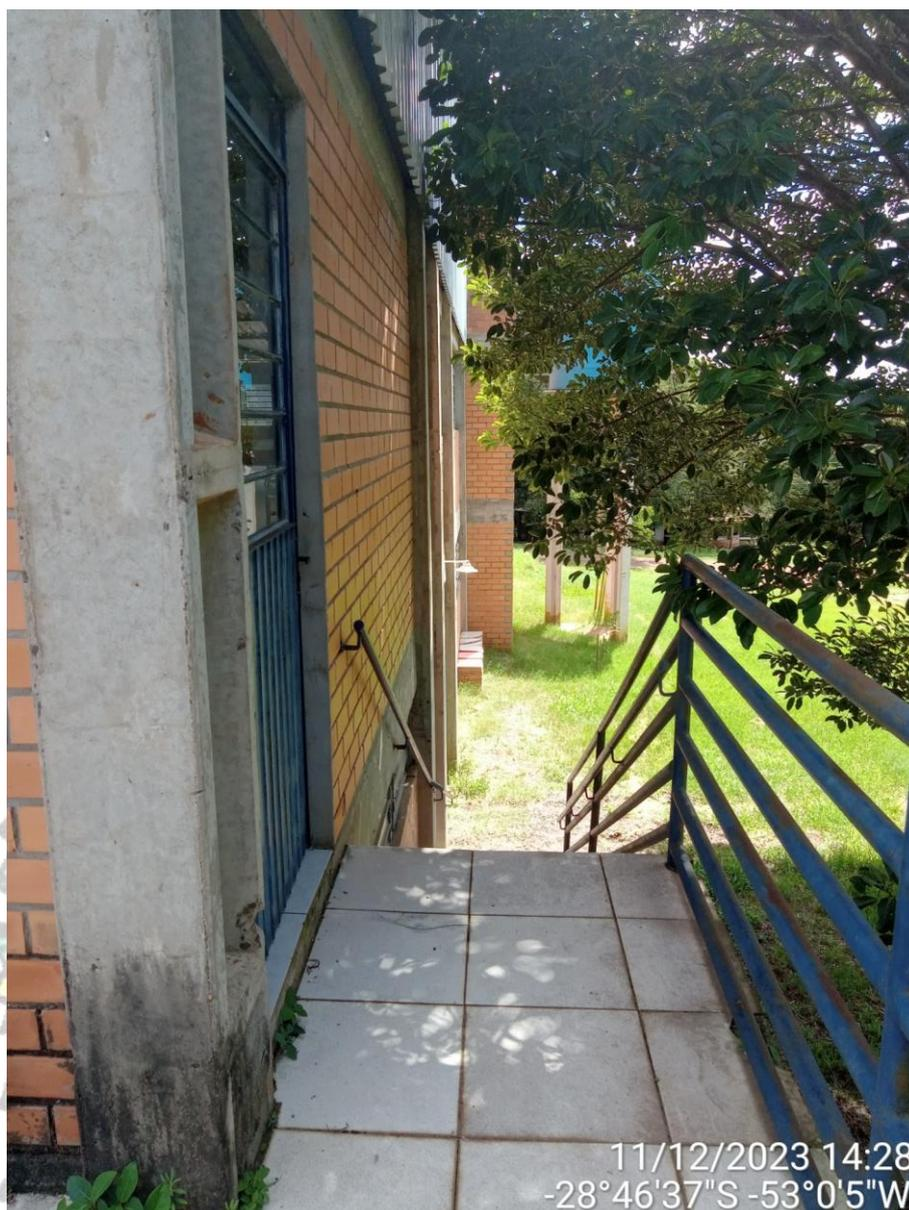
**Figura 25 – GUARDA-CORPO E CORRIMÃO EXISTENTES**
