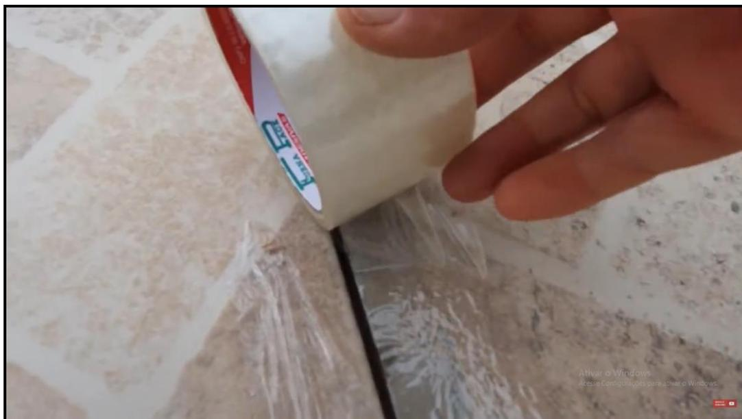
**Figura 28 – JUNTA DE DILATAÇÃO – EXECUÇÃO 1**
