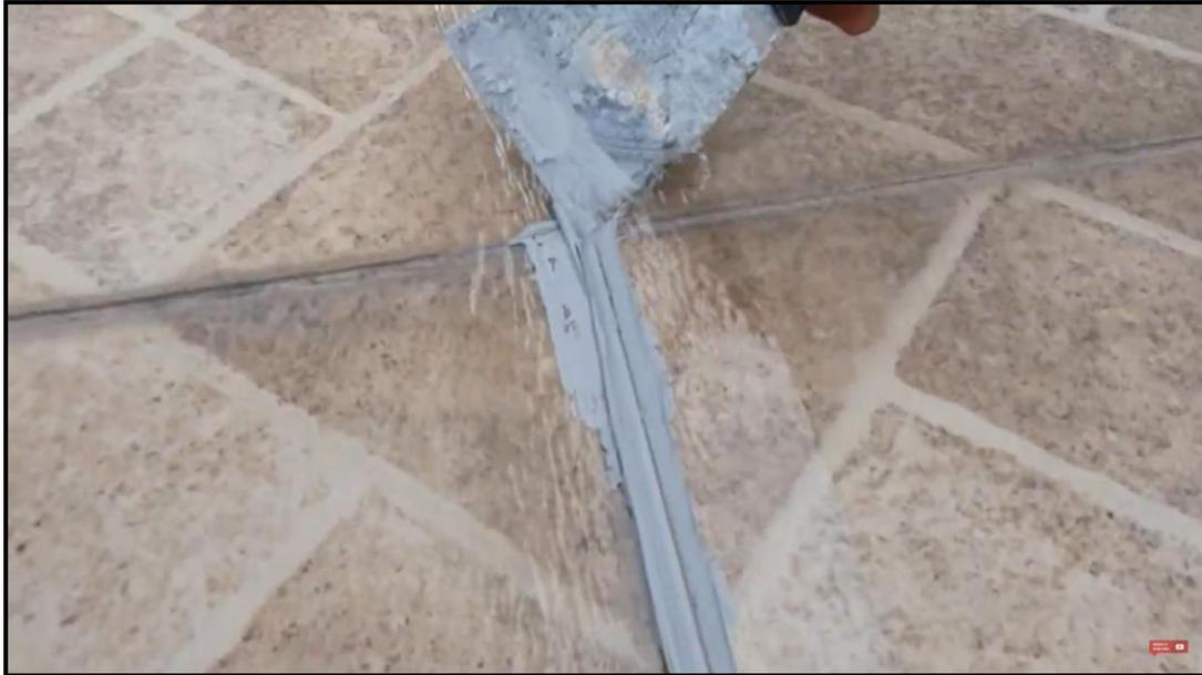
**Figura 32 – JUNTA DE DILATAÇÃO – EXECUÇÃO 5**
