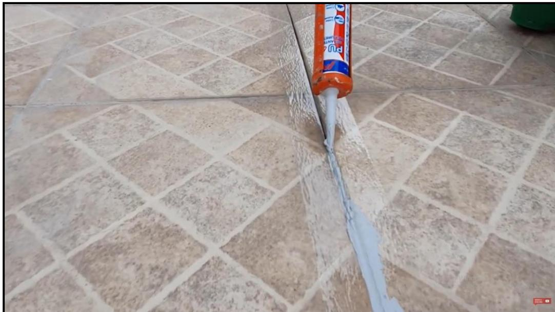
**Figura 30 – JUNTA DE DILATAÇÃO – EXECUÇÃO 3**
