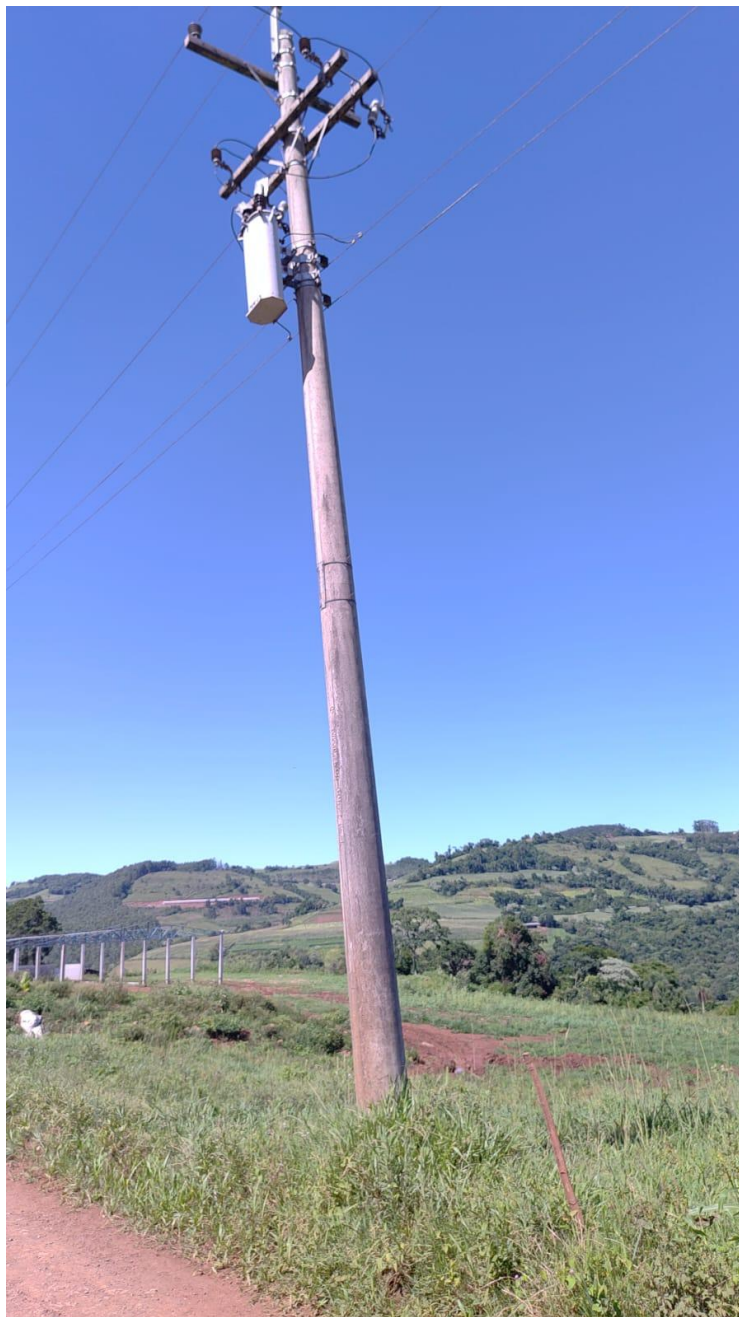
Figura 5 - Transformador trifásico.
