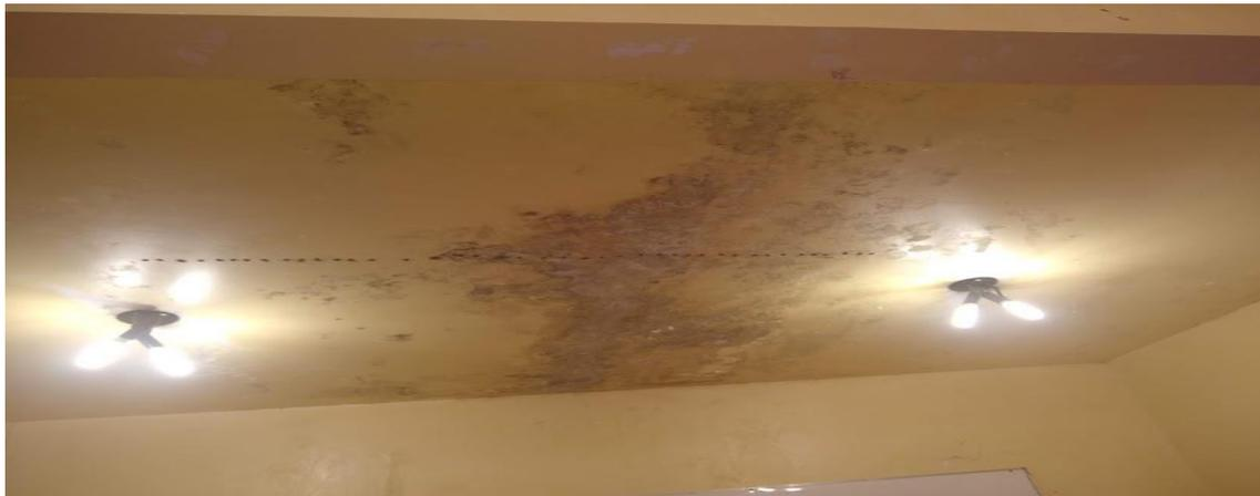
Imagem 1: interior de sala, laje com umidade, mofo, bolor, corrigindo pintura, revestimento e impermeabilização da cobertura
