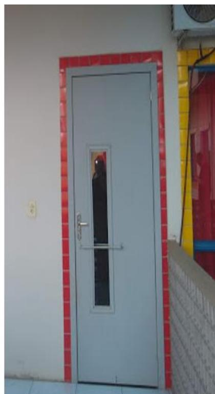
Imagem 2: portas existentes, sem a chapa de proteção metálica na parte inferior
