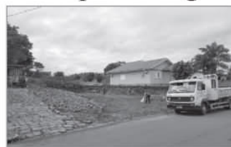
Obras do prédio estão iniciando
