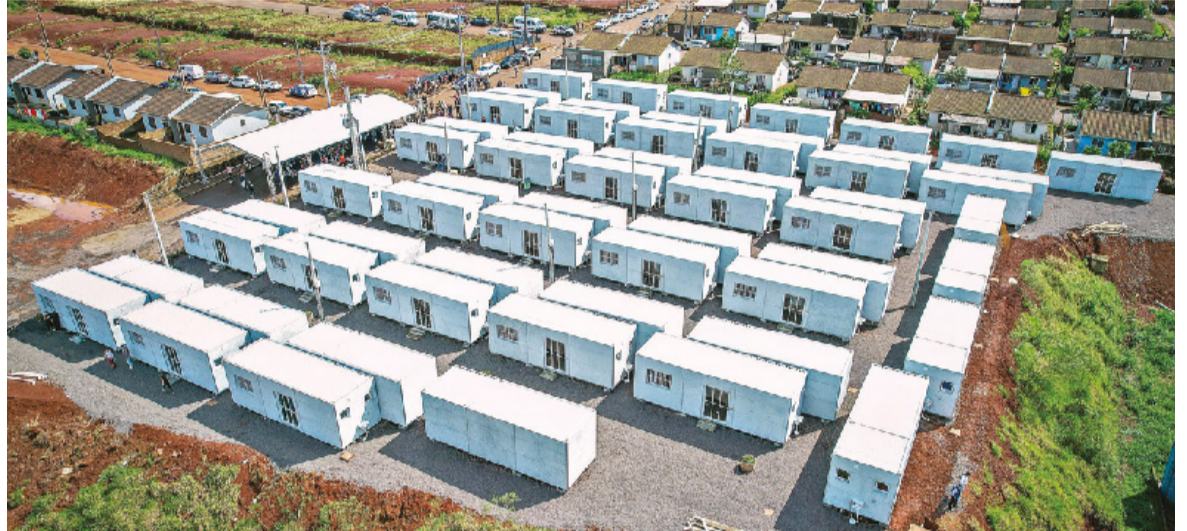
Módulos habitacionais, com 27 metros quadrados, foram instalados nos bairros Novo Paraíso e Imigrantes
