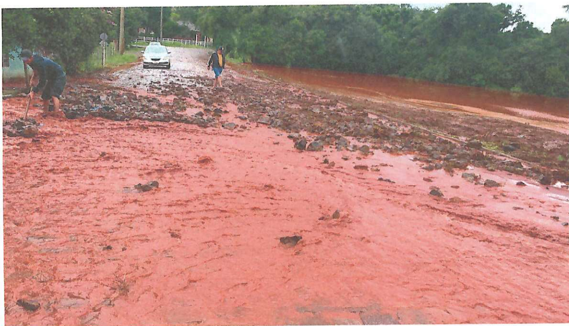
Foto 18 e 19: Estrada localidade Saída para Posse Barão. Rua Olivério Guntzel.
