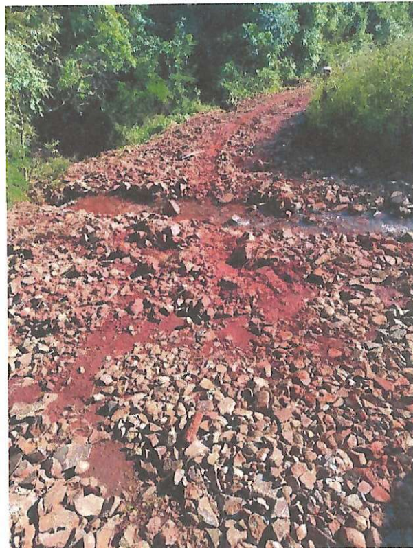
Foto 17: estrada localidade Pessegueiro proximo as propriedades Selmira Born e Pedro Licio coordenadas geograficas Inicio Lat: -28.443487°Long:-52.578600° Fim Lat -28.443750°Long: -52.578362°
