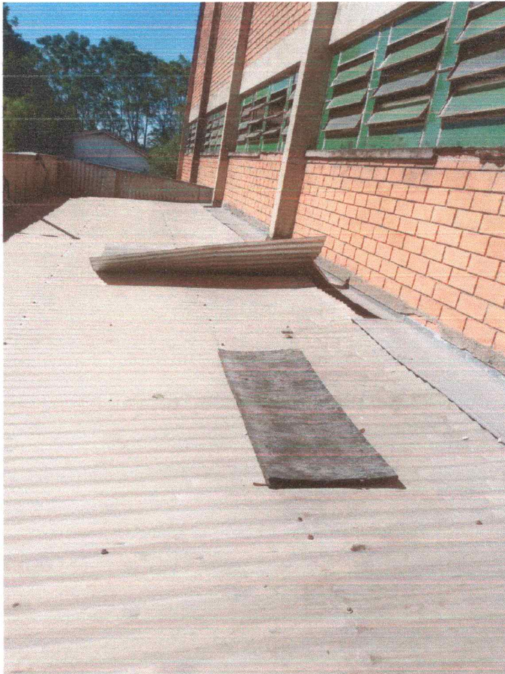
Figura nº 01 – Detalhe do desprendimento da telha.
