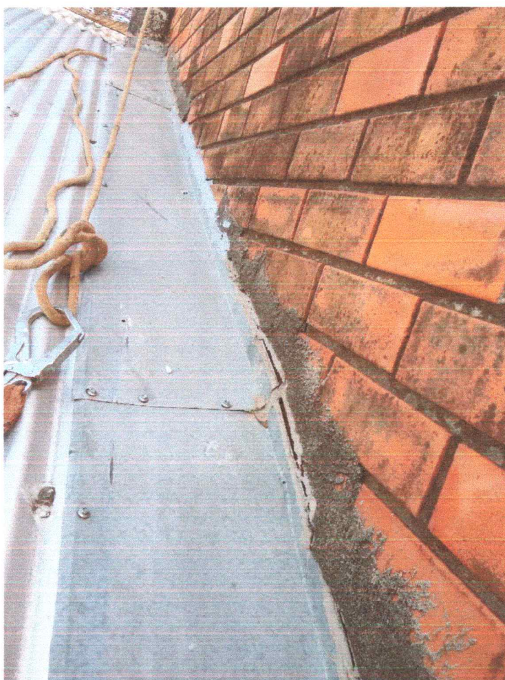
Figura nº 04 – Trinca no material selante dos Rufos.
