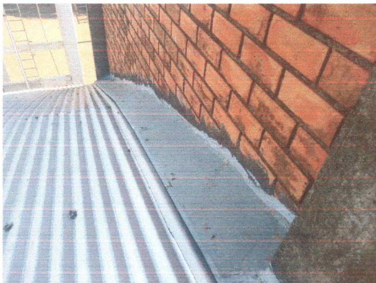
Figura nº 08 – Detalhe da vedação recuperada dos Rufos.
