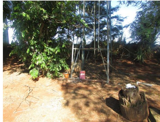
Figura 2.15 - Ponto de captação da Santo Inácio.
