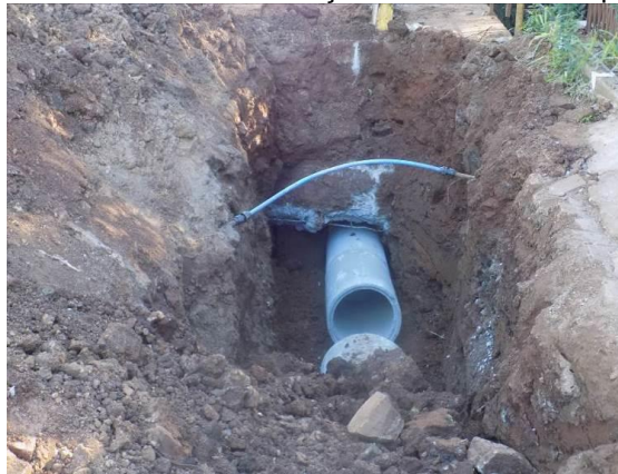
Figura 5.2 - Foto da canalização no Distrito do Depósito.
