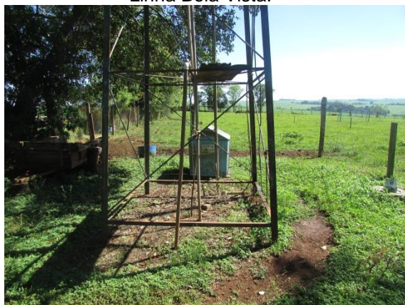
Figura 2.12 - Ponto de captação da localidade Linha Bela Vista.
