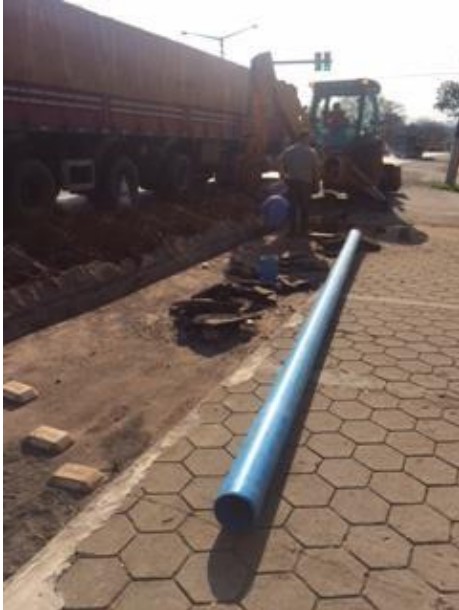
Figura 2.10 – Manutenção de rede de distribuição de água potável.
