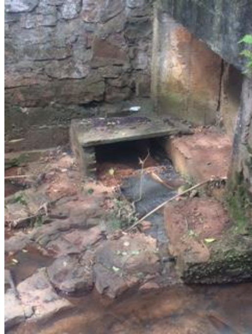
Figura 3.13 - Córrego onde é descartado esgoto sanitário in natura.
