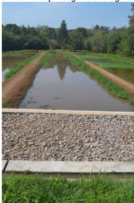
Figura 3.6 - Baia de infiltração seguida das lagoas de maturação.
