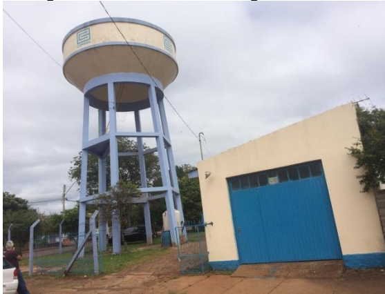
Figura 2.6 - Reservatório água tratada.
