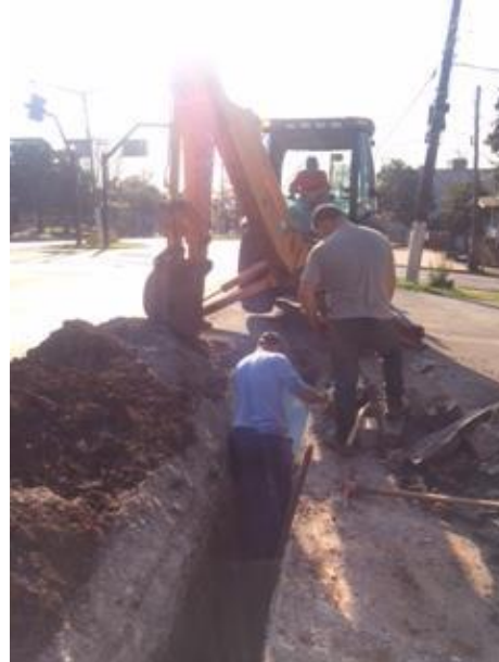
Figura 2.11 – Ampliação de rede de distribuição de água potável.
