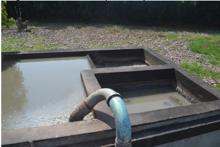
Figura 3.4 – Gradeamento para remoção de sólidos finos.
