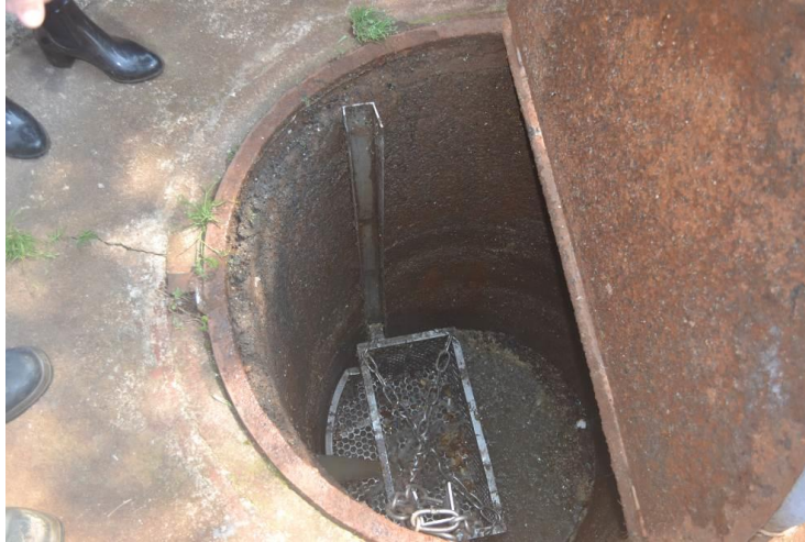
Figura 3.3 - Ponto de chegada do esgoto na ETE.
