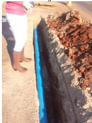
Figura 2.9 – Ampliação de rede de distribuição de água potável bairro São Jorge.
