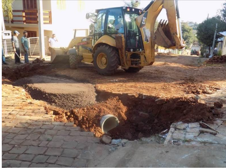
Figura 5.7 - Construção de bocas de lobo.
