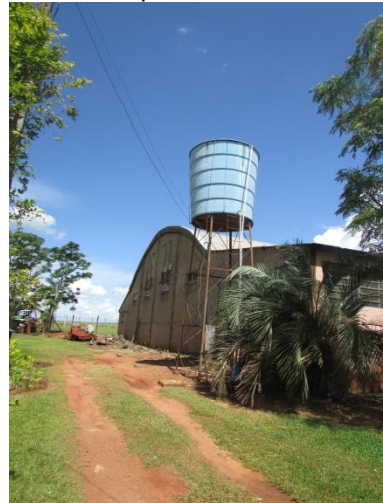
Figura 2.21 - Ponto de captação da Campina Redonda.
