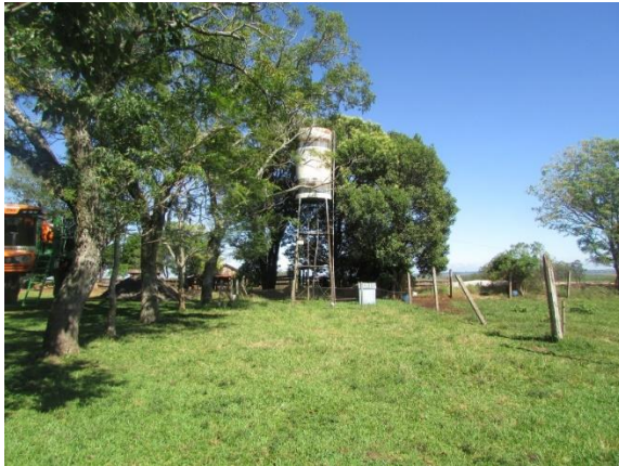
Figura 2.18 - Ponto de captação da localidade Linha Bela Vista.
