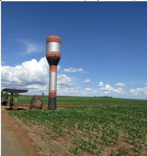
Figura 2.20 - Ponto de captação da Depósito.
