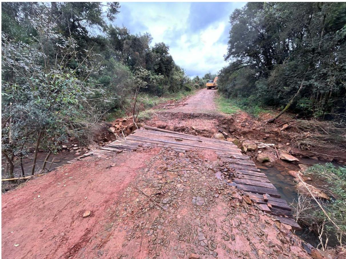
Foto 02 – Situação da ponte após o colapso (02/05/2024)
