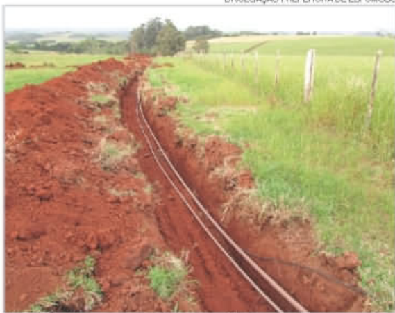
Instalação de novas redes d'água intensificada
