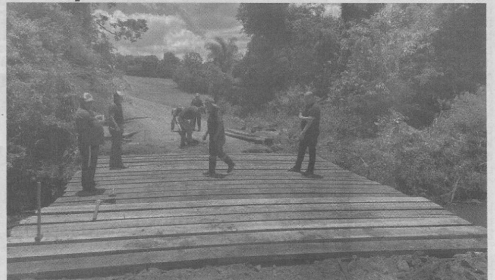
Trabalho sendo executado pela equipe da SMOT nesta semana
