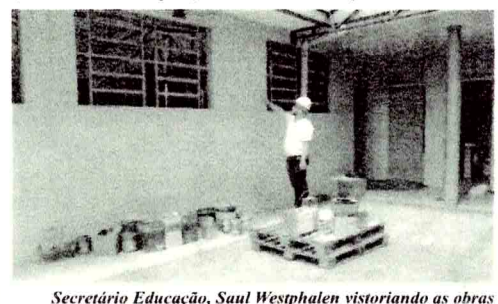
Secretário de Educação, Saul Westphalen visitando as obras
