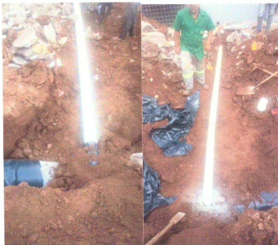
Fotos 08 e 09 - Ligações de esgoto
