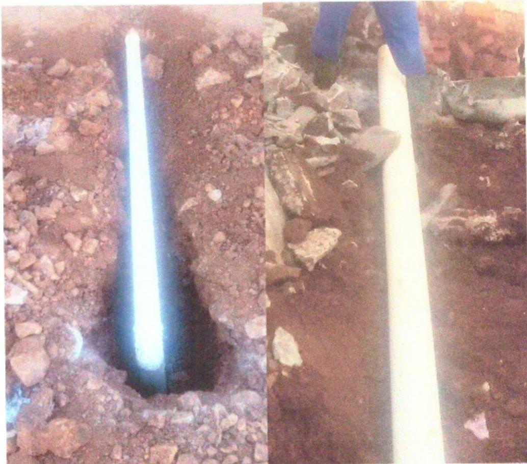
Fotos 05e 06 – Ligações de esgoto
