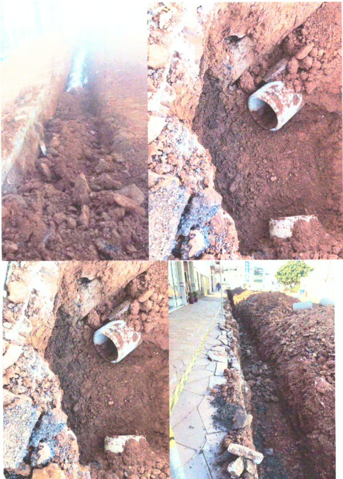
Fotos de 11 a 14 – Encontro de tubulação 400mm com a 600mm
