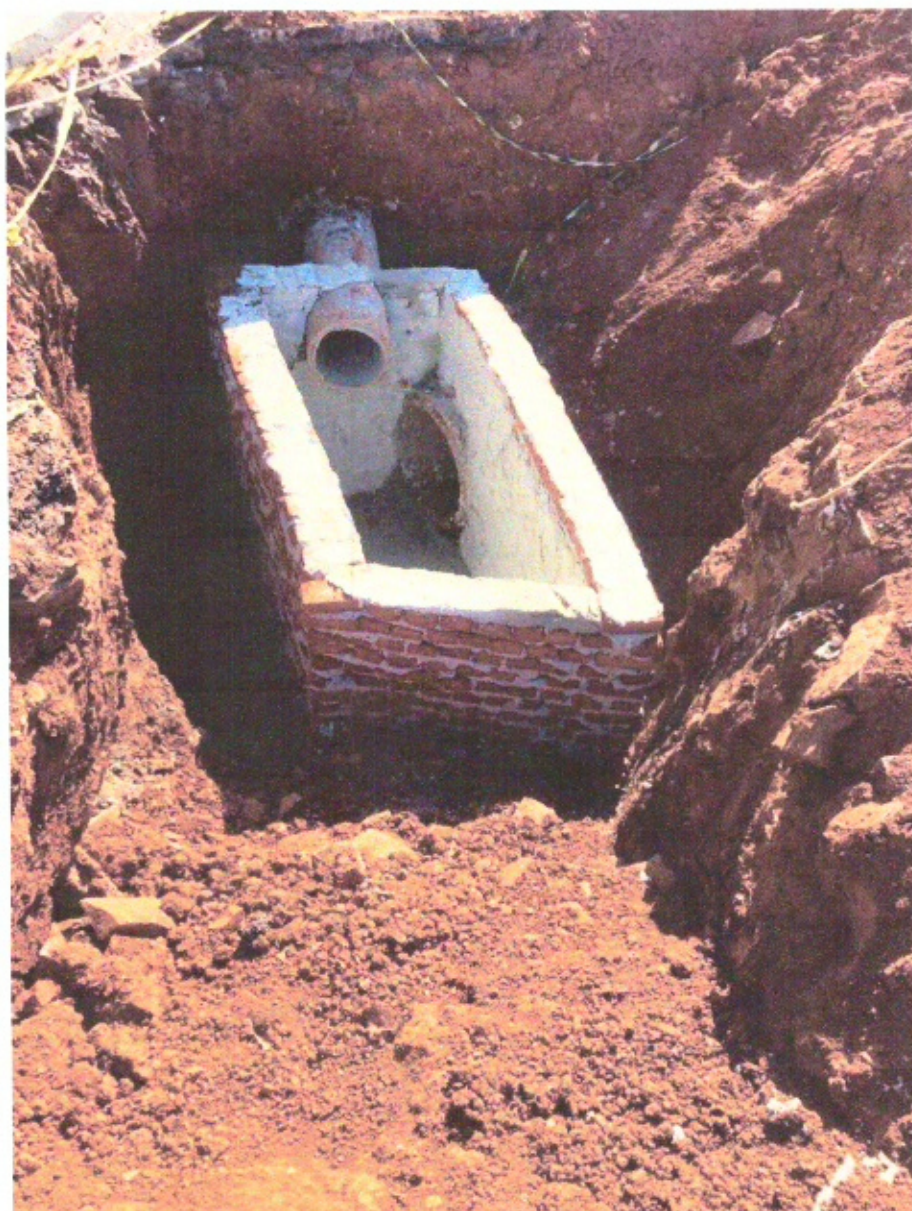
Foto 10 – Encontro de tubulação 400mm com a 600mm
