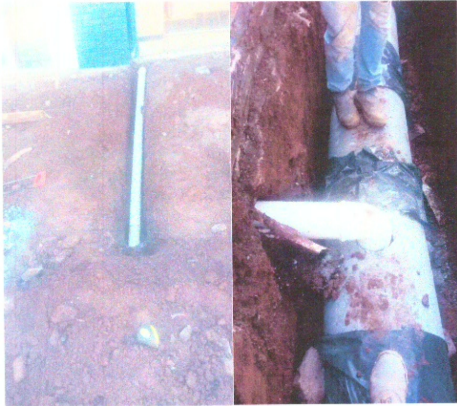
Fotos 03 e 04 – Ligações de esgoto
