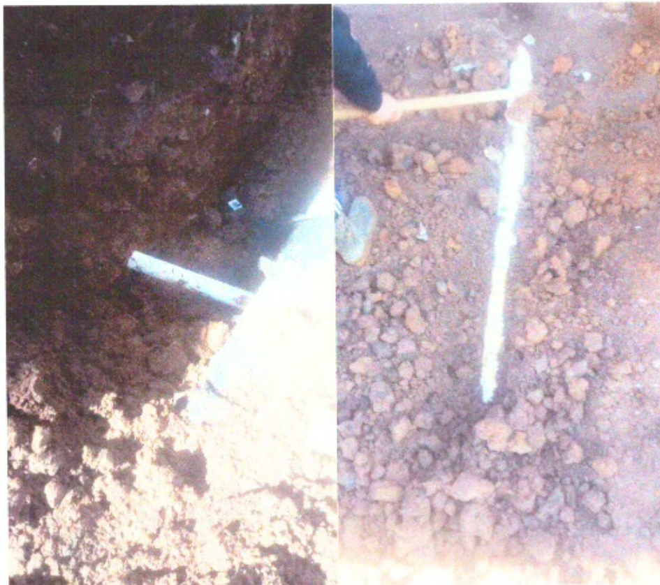
Fotos 06 e 07 - Ligações de esgoto
