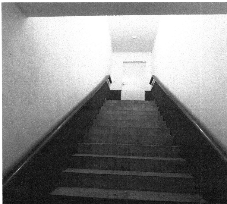
Foto 5: Corrimão instalado
