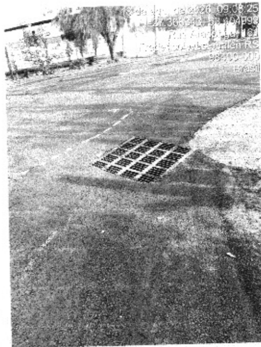
Foto 03 – Acabamento caixas pré-moldadas e pavimentação.
