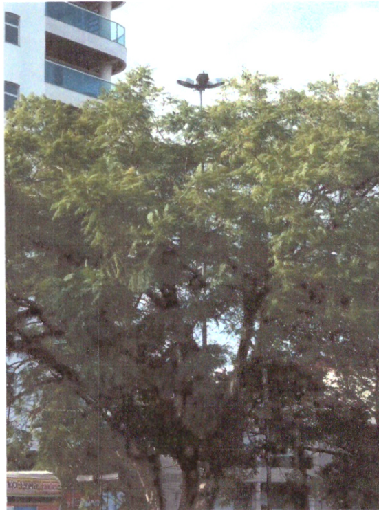
Figura 6 – Vista lateral da luminária, que está sendo obstruída pela vegetação local.
