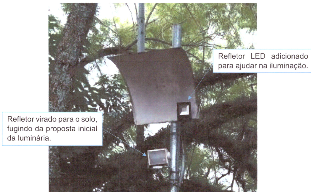
Figura 2 – Particularidades encontradas nas luminárias.
