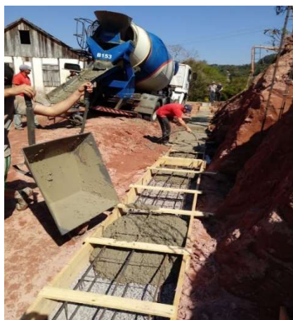
Execução de viga base.
