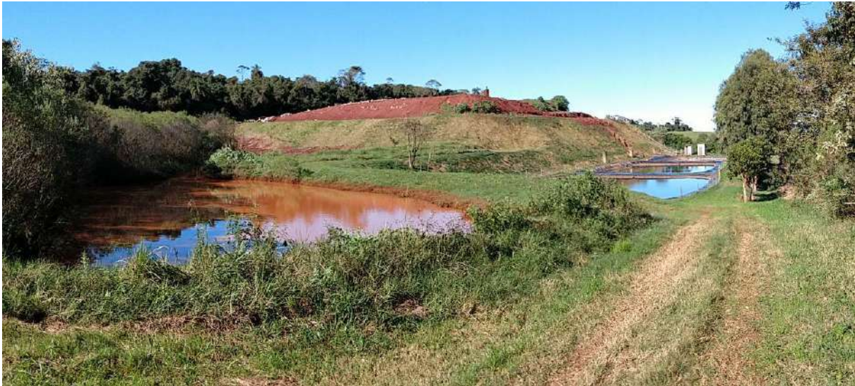
Figura 2: Vista geral da área, mostrando em primeiro plano a bacia de contenção pluvial.
