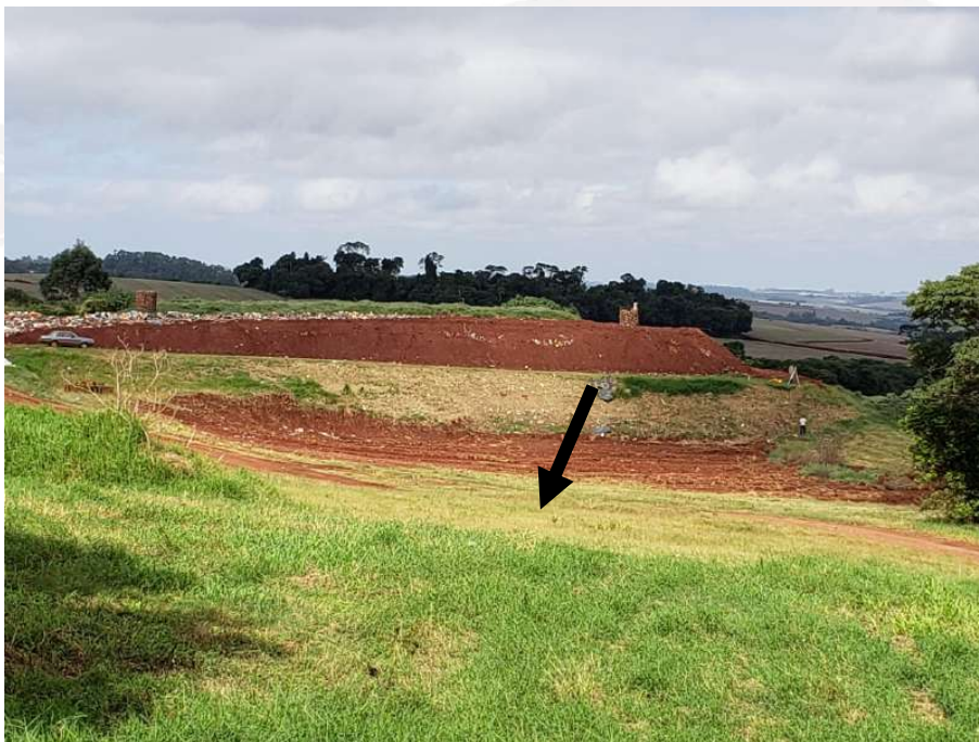
Local da ampliação do aterro
