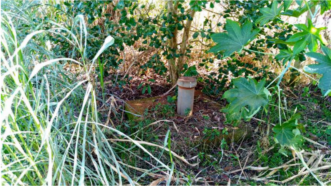
Poço de monitoramento – PM 01
