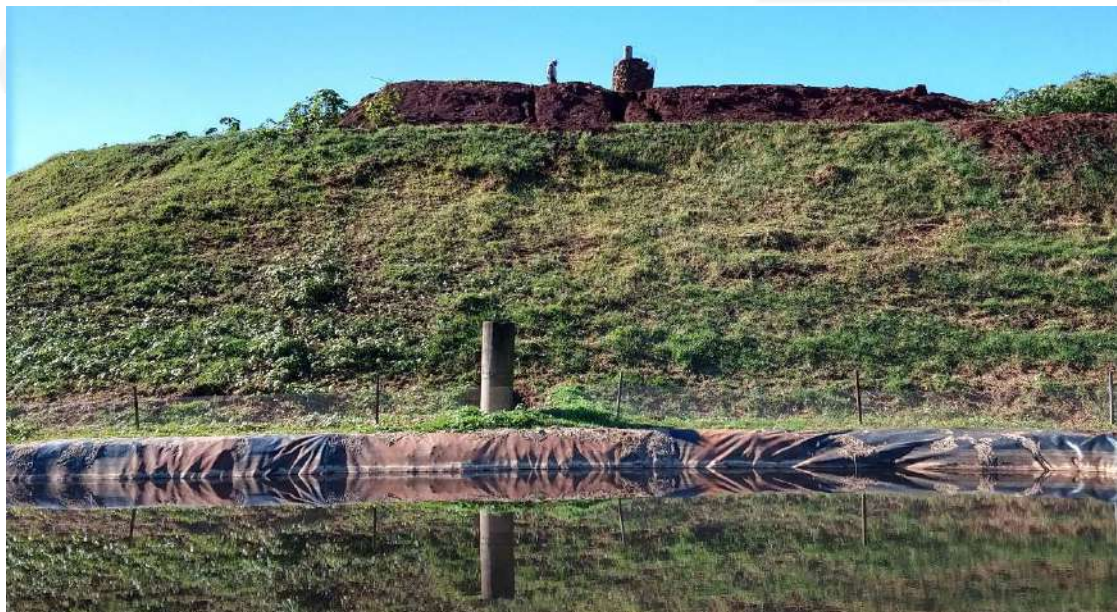
Figura 3: Vista da Lagoa 2, ao lado do talude oeste da Célula 1. No topo da imagem aparece um operador do aterro caminhando próximo a um dreno vertical.
