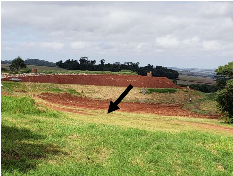
Local de ampliação do aterro
