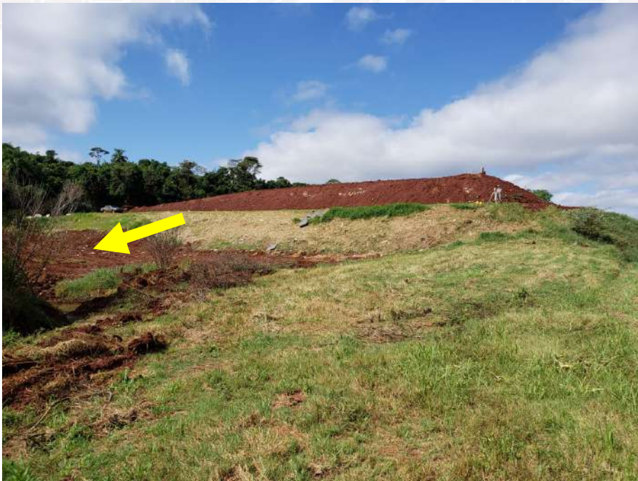
Local para ampliação do aterro
