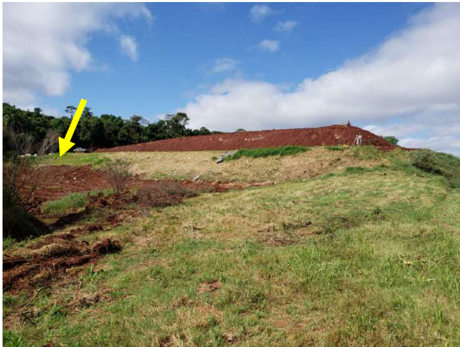
Local para ampliação do aterro
