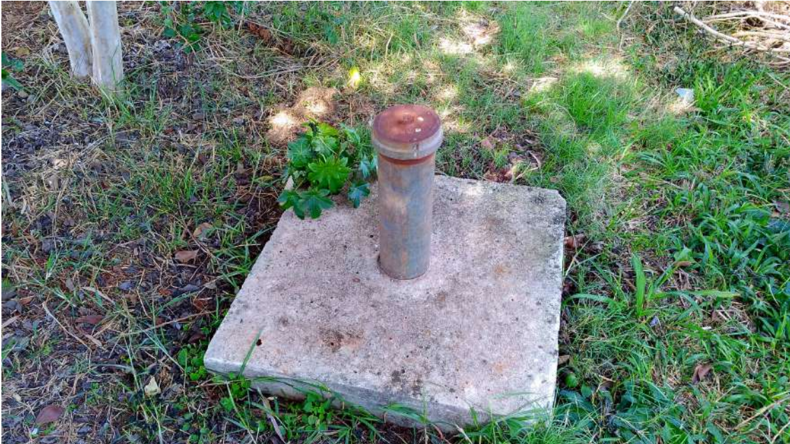
Poço de monitoramento – PM 03
