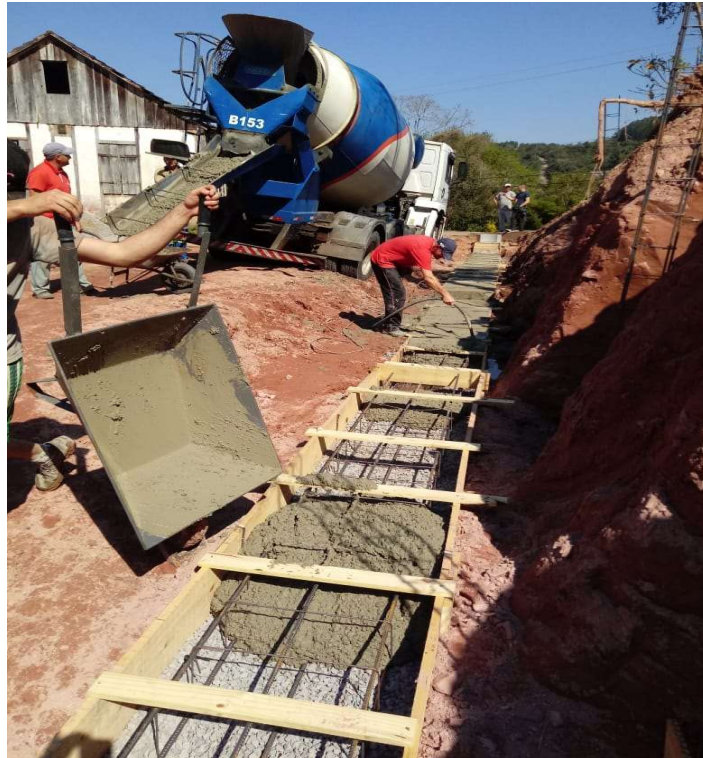
Exemplo de concretagem de base de Muros.
