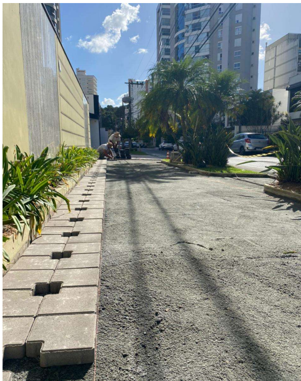
Exemplo execução Piso intertravado sobre pó de pedra.
