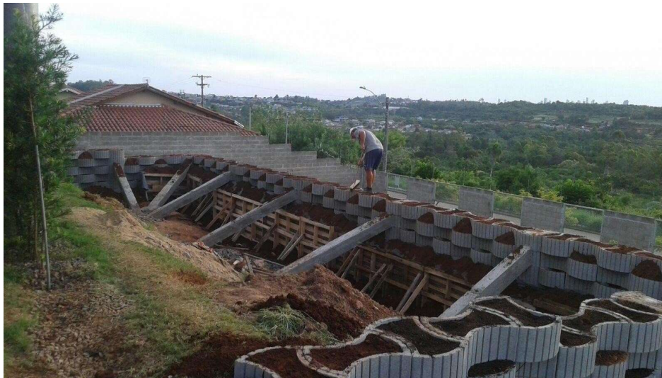
Perspectiva do muro que será executado no local.
