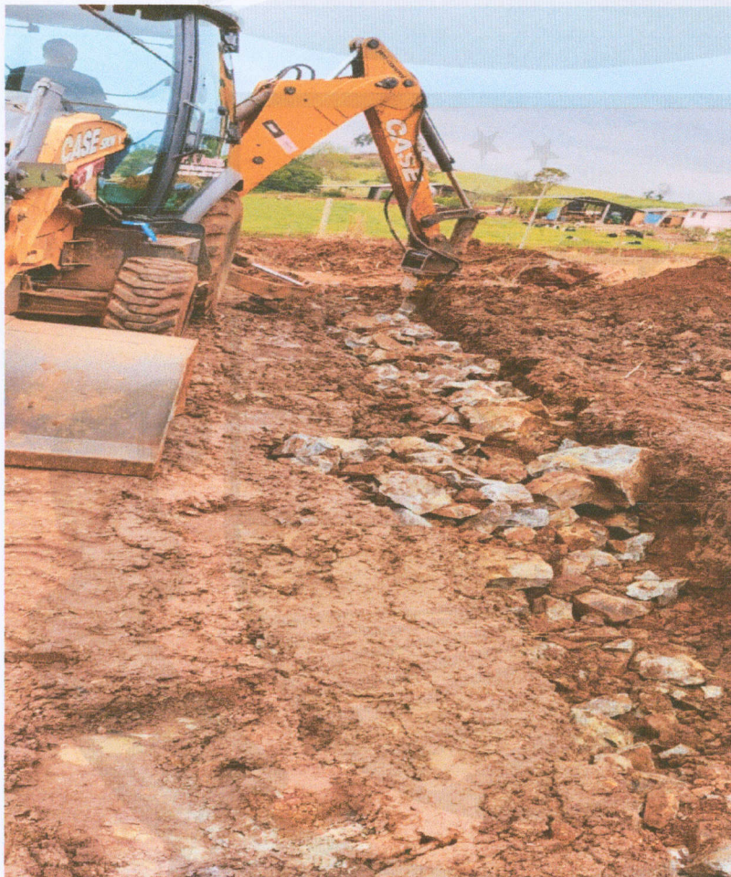
-Imagem durante remoção existente
