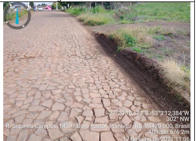
Figura 12 – Local remendo profundo
