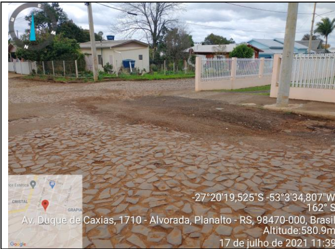
Figura 13 – Local remendo profundo
