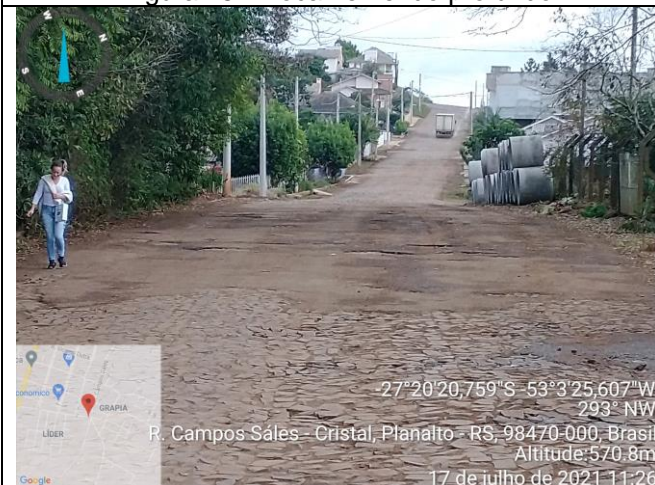
Figura 17 – Local remendo profundo
