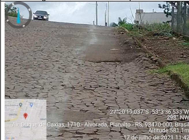
Figura 15 – Local remendo profundo
