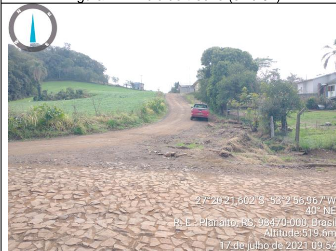
Figura 3 – Início do trecho Rua Miguel Zaleski
