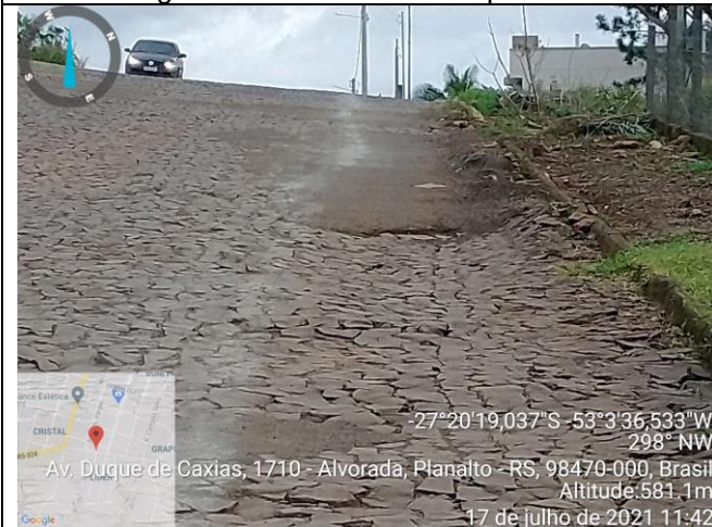
Figura 15 – Local remendo profundo
