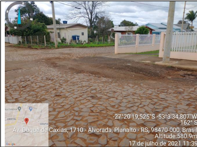
Figura 13 – Local remendo profundo
