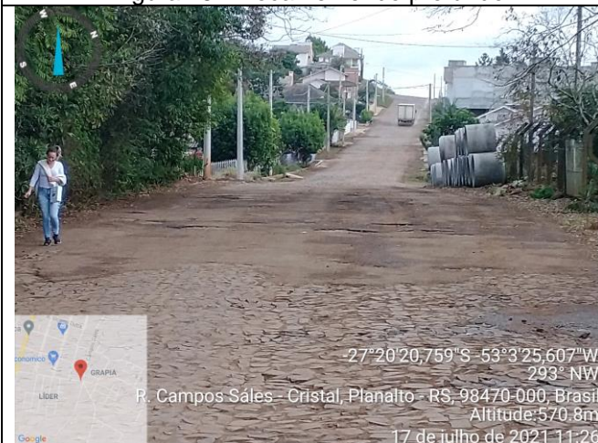
Figura 17 – Local remendo profundo
