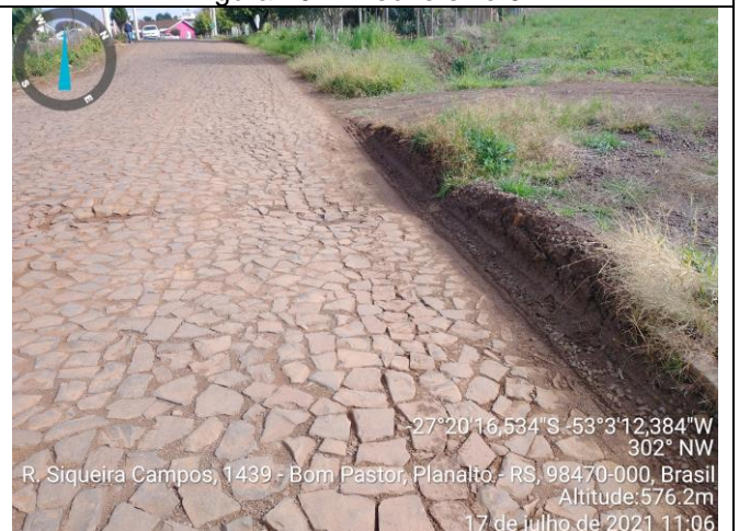
Figura 12 – Local remendo profundo
