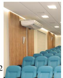
15mm, de duplo revestimento, instalados desde o chão até o forro. Poderão ser fixados diretamente a parede. No auditório será instalado 3 painéis na parede leste, sendo de 1,70m de largura a 15cm do forro e do piso; 2 painéis na parede oeste, sendo de 2,00m de largura a 15cm do forro e do piso; No palco nas duas laterais da chapa ACM, sendo de 2,00m de largura a 15cm do forro e do piso.
