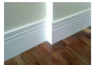
PVC na espessura de 16mm, e altura de 15cm. Serão fixados a parede com parafusos e buchas, devendo ser colocado acabamento superficial sobre o parafuso que o esconda. O acabamento deverá ser idem ao rodapé.
