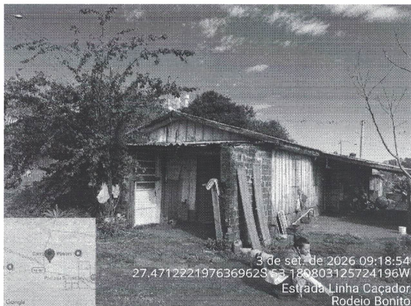
Figura 2 — Vista externa de imóvel na Estrada Linha Caçador, integrante do núcleo de registros realizados no local.
