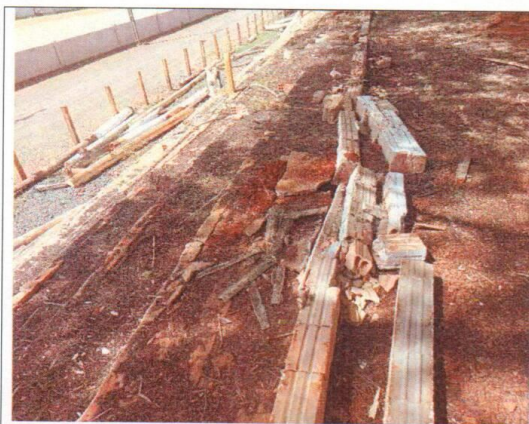
Imagem depois da retirada das estruturas de madeira
