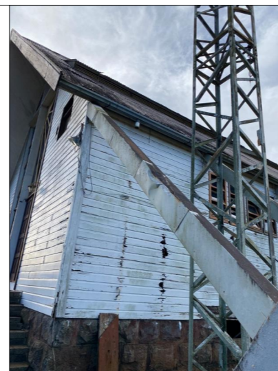
Limpeza e revitalização
