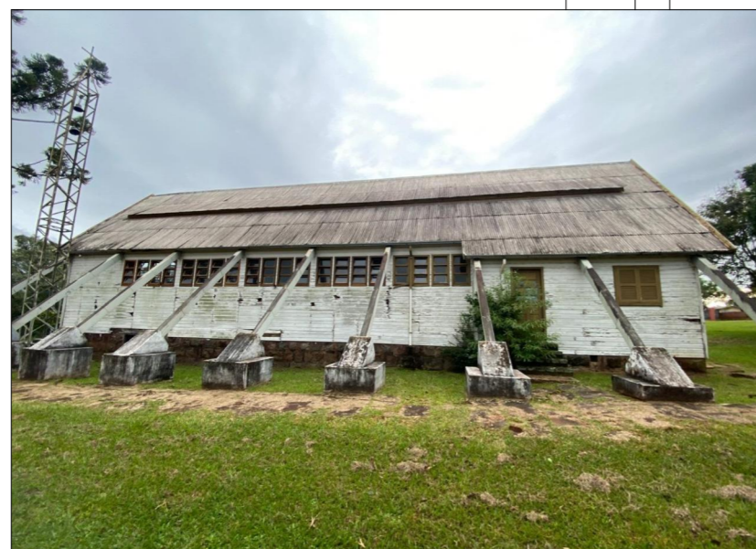
Substituição das madeiras
