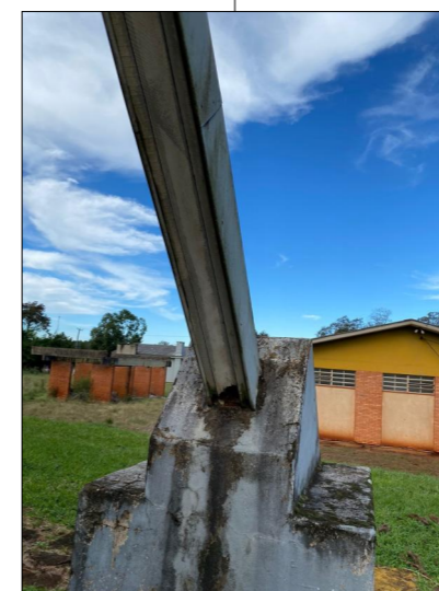
Substituição das madeiras
