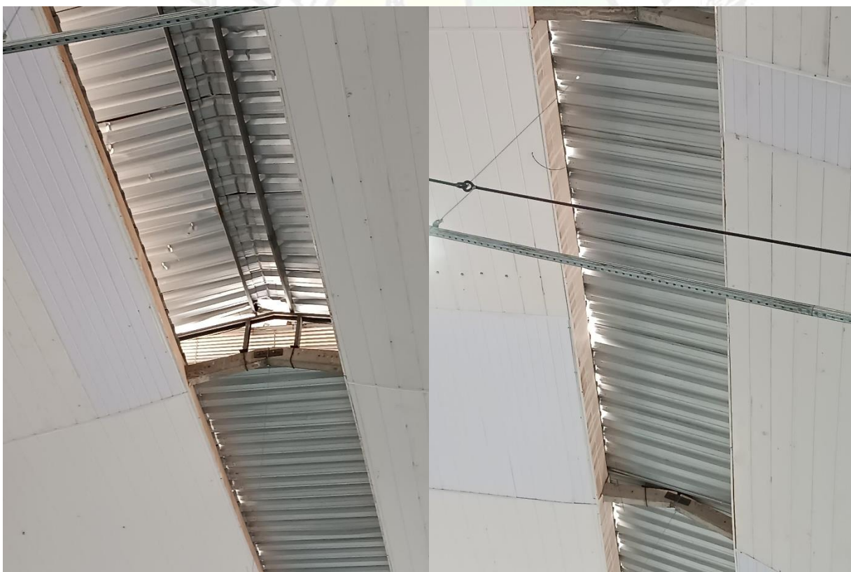
Imagens 1 e 2 internas – focos de luz onde possivelmente à entrada de chuva
