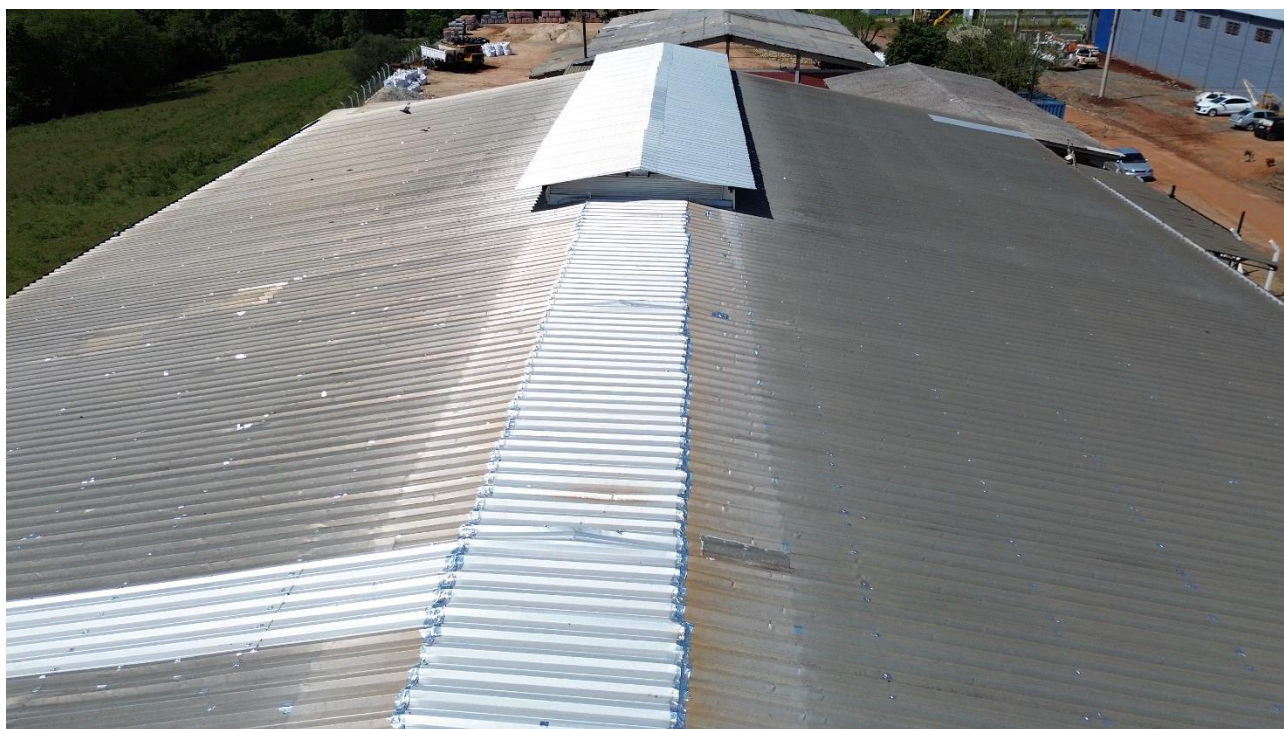
Imagem 7 externa – visão do lanternim à direita que foi restaurado em outra etapa anterior
