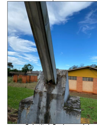
Substituição das madeiras
