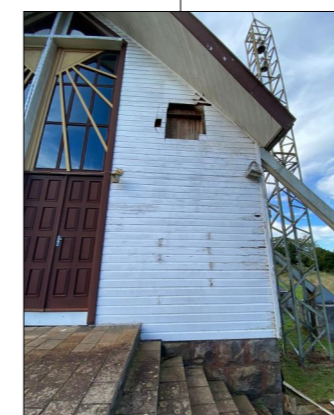
Substituição das madeiras
