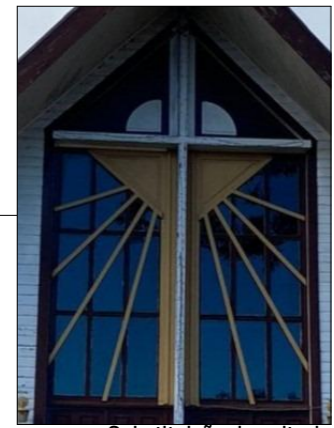
Substituição dos vitrais
