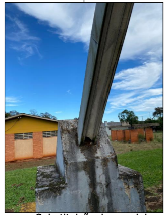
Substituição das madeiras
