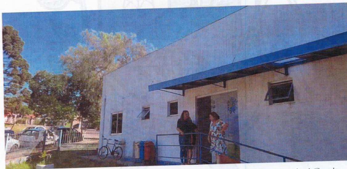
Imagem da farmácia básica – todo o perímetro do telhado é fechado pela platibanda
