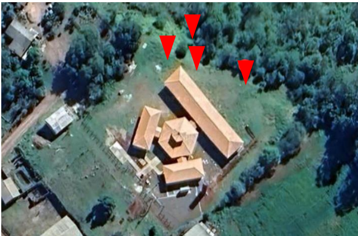
Figura 4 - Localização dos ensaios de sondagem a trado.
