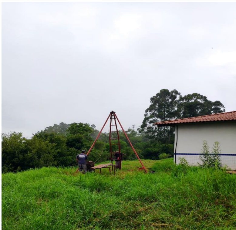
Figura 2 - Execução do ensaio de sondagem SPT.
