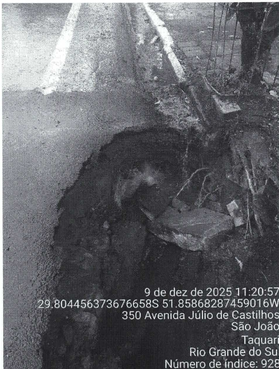
Foto 02: Vista tubulação da Corsan rompida vazando água.
