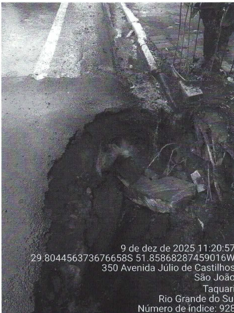
Foto 02: Vista tubulação da Corsan rompida vazando água.
