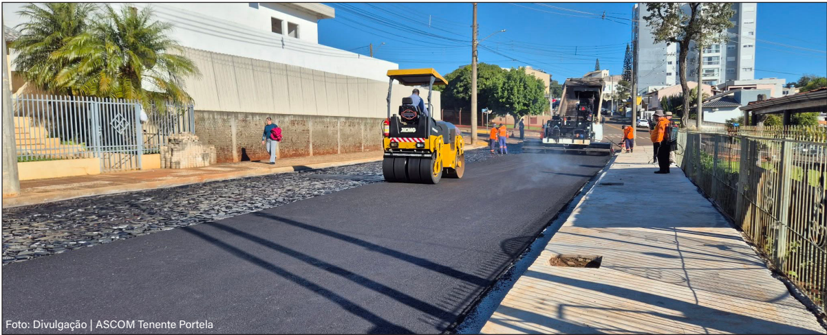
Asfaltamento das três ruas integra o programa municipal “Obra pra Todo Lado”
