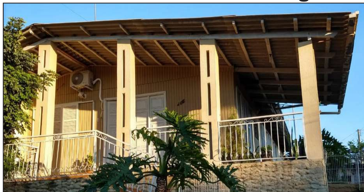
Residência de Teresa Thums, interior de Boa Vista do Buricá.
