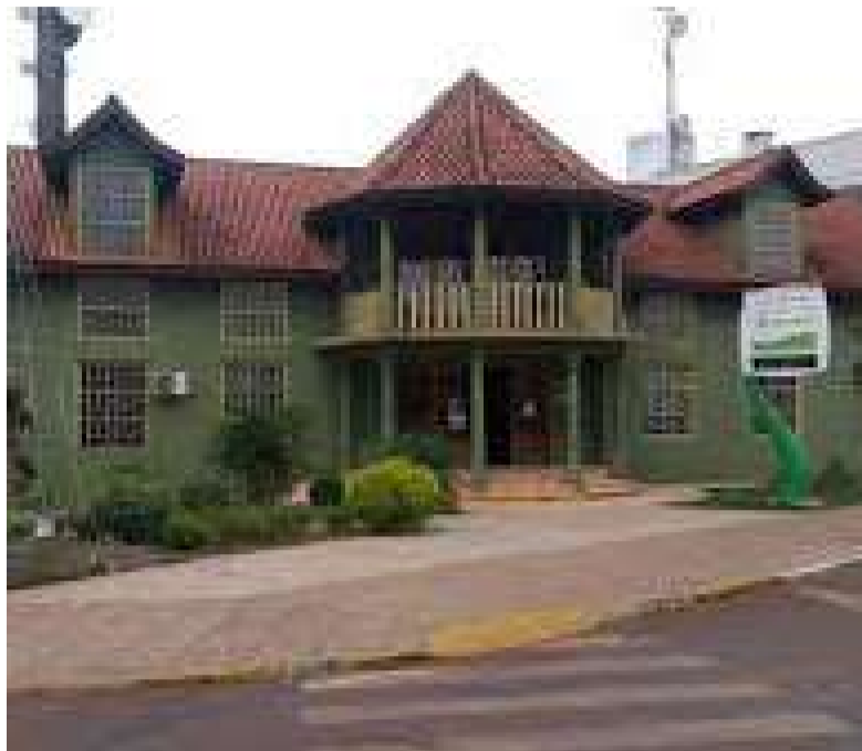
Demais setores da estrutura seguem funcionando normalmente
